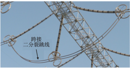
(a)带跳线绝缘子串
